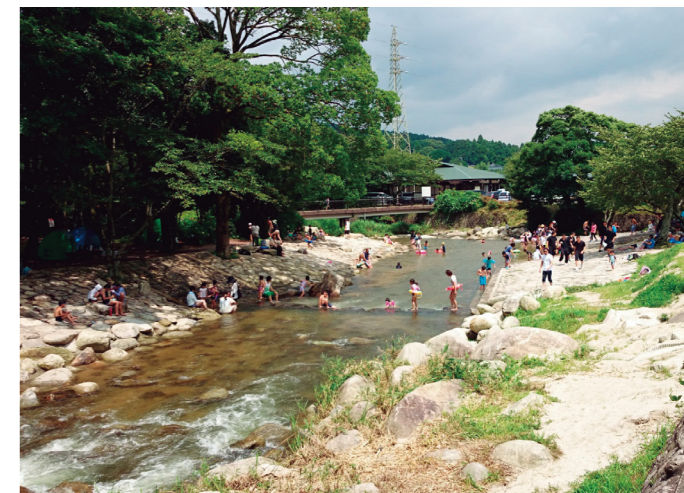
流れが速くなるよう、狭い間隔で飛び石を設置
