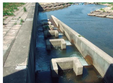
土砂を除去し、水制工を設置したところ、下流部の土砂堆積を抑制することができました。
